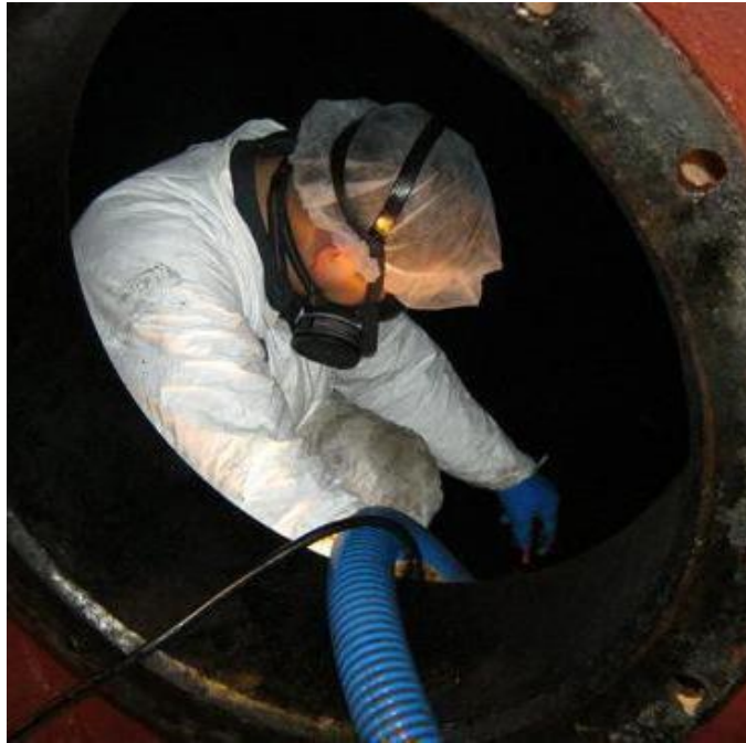
Рис. 4. Внутрішній огляд та зачистка резервуару нафтопродуктів
