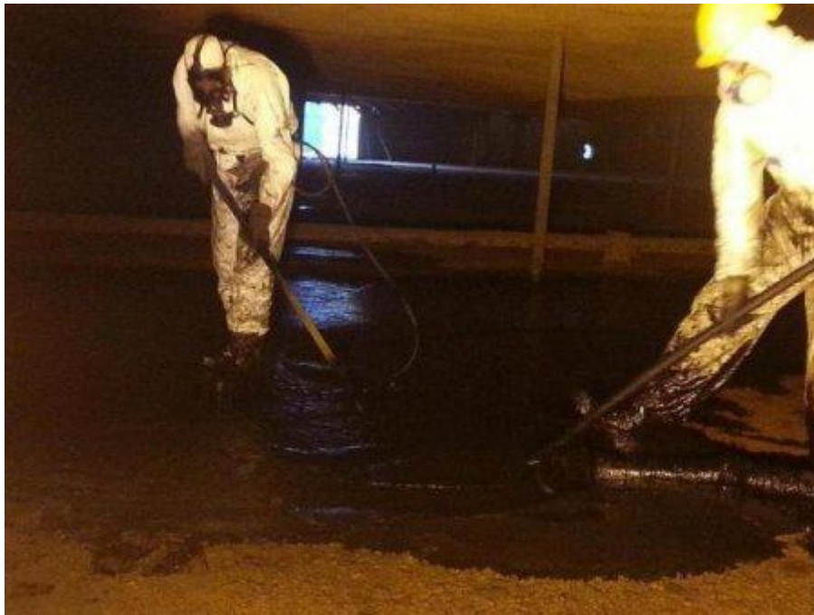
Рис. 6. Зачистка резервуару нафтопродуктів шляхом ліквідації відходів
