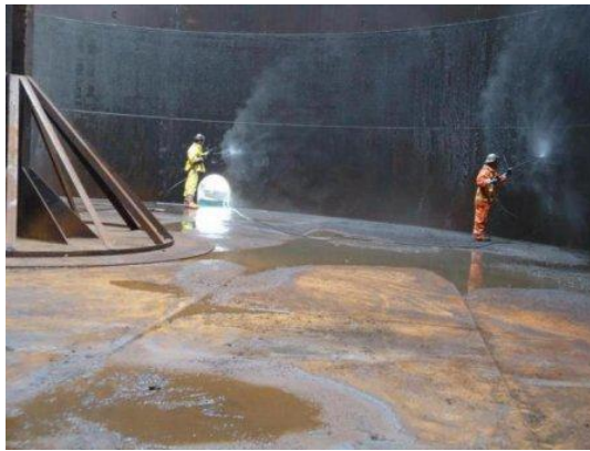
Рис. 5. Газоповітряна зачистка резервуару нафтопродуктів
