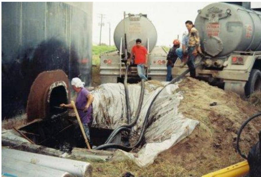
Рис. 3. Зовнішня зачистка резервуару нафтопродуктів
