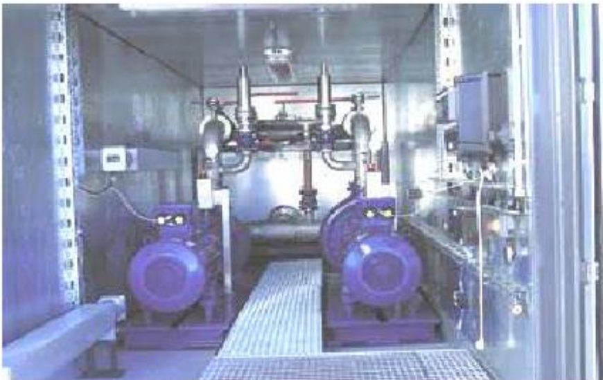
Рис. 15 Насосна станція контейнерного типу в арктичному виконанні
