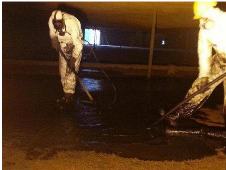
Рис. 6. Зачистка резервуару нафтопродуктів шляхом ліквідації відходів
