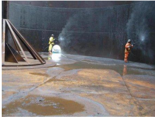
Рис. 5. Газоповітряна зачистка резервуару нафтопродуктів
