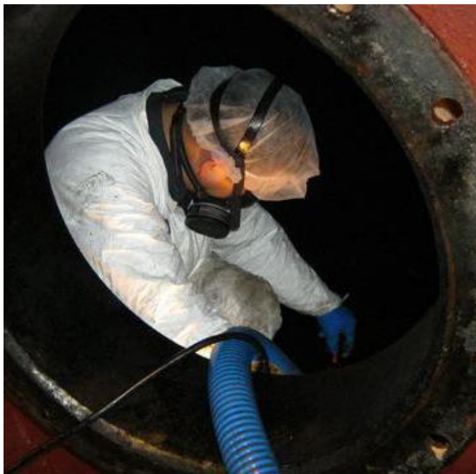
Рис. 4. Внутрішній огляд та зачистка резервуару нафтопродуктів
