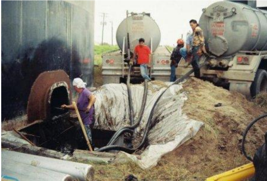
Рис. 3. Зовнішня зачистка резервуару нафтопродуктів
